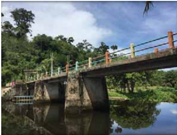
Jembatan yang menghubungkan arus Danau Bukit Layang.
