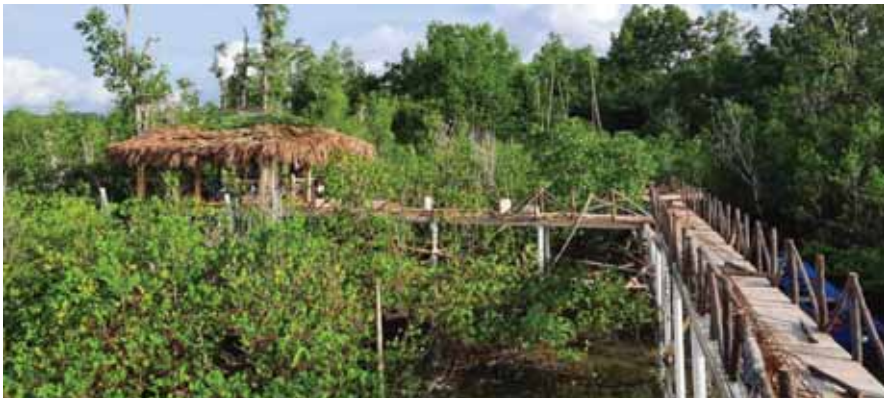
Progress Pembangunan Mangrove Trail Pulau Kayu
